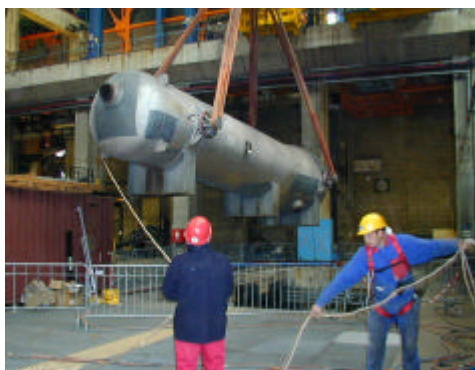
déconstruction de la salle des machines, sortie d'un réchauffeur haute pression
